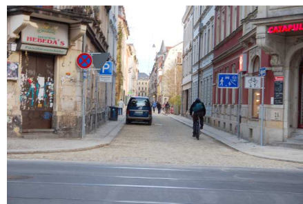
Sanierte Böhmisches Straße
