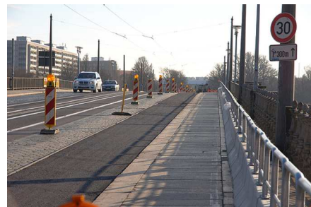
Umbau an der Albertbrücke
