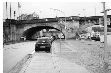
Der „Radweg“ unter der Augustusbrücke ist ständig zugeparkt
