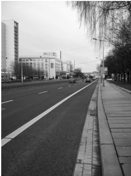
Neuer Radstreifen auf der Grunaer Straße
