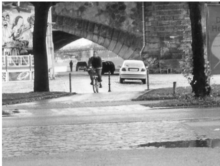
Neuer Elberadweg unter der Marienbrücke
