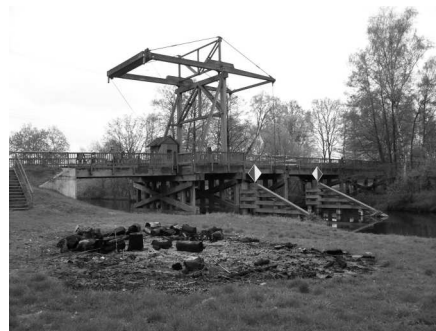
Eine hölzerne Zugbrücke bei Briesch
