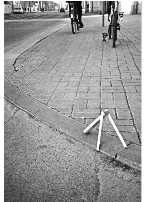
Entschärfter Bordstein auf der Großenhainer Straße
