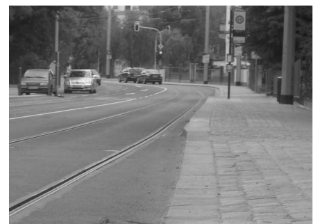
An den Fahrbahnrand führende Schienen müssen im spitzen Winkel gequert werden
