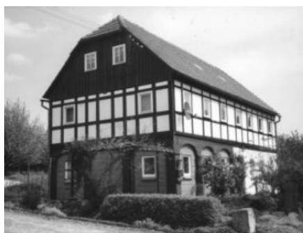
Umgebinderhäuser, bestehend aus einer slavischen Blockhütte und fränkischem Fachwerk, sind die traditionelle Bauform der Oberlausitz
