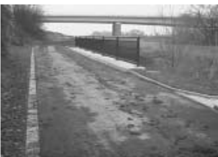
Die sanierte Zschonerbachbrücke
