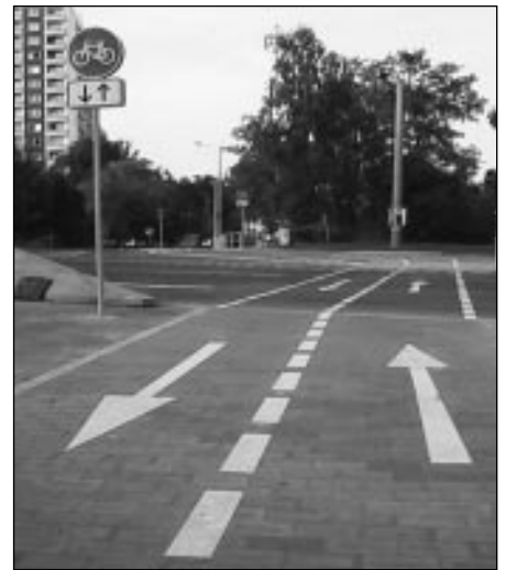
Blick von der Mittelinsel in Richtung Hochschulstraße
