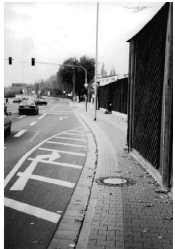
Engpass auf dem Radweg der B172
