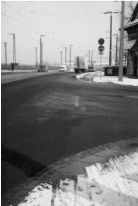
Von Süden kommend vor der Auf-fahrt: Die bösen Längsrillen des früheren Basaltpflasters sind glattem Asphalt gewichen.
