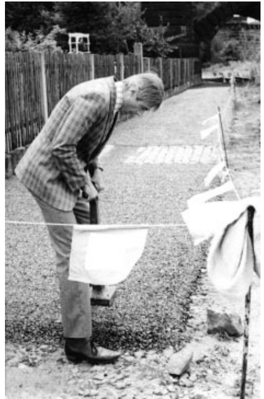
Der Autor beim Radwegbau an der Marienbrücke
