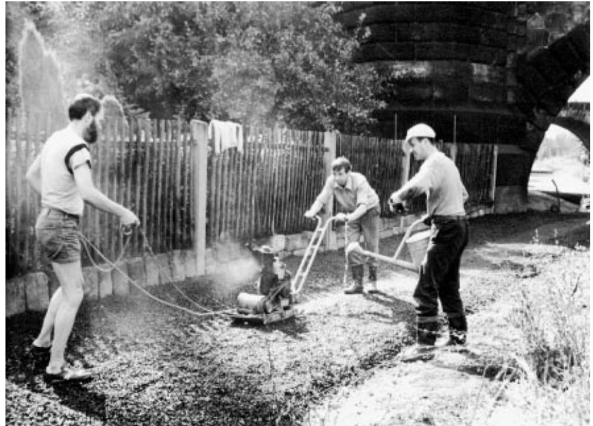
Radwegebau unter der Marienbrücke (v.l.n.r. Gottfried Lobeck, Werner Schmiededecke und Hartmut Dressel)
