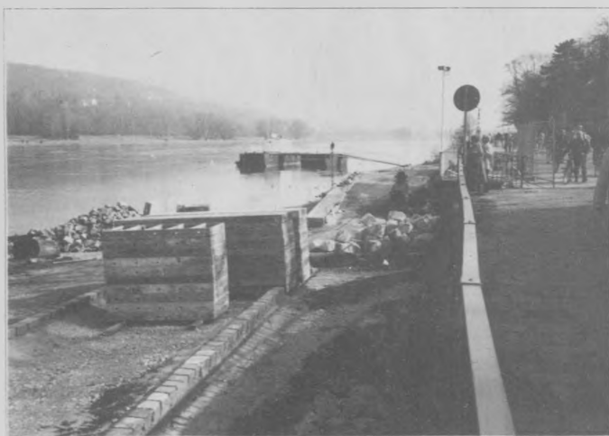
Unter dem Blauen Wunder entsteht aus Geldern des Vorjahres eine Rampe, die am Schillergarten eine konfliktrichtige Lücke am Elbradweg schließt.
