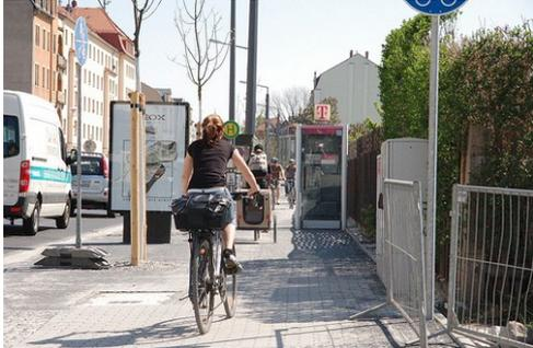
Abbildung 3: Leipziger Straße nach Sanierung: Radfahrer (auch in Gegenrichtung) auf teilweise 1,50 m Breite
