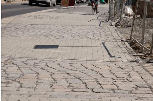
Abbildung 4: Leipziger Straße nach Sanierung: Betonpflaster an Einfahrten mit Großpflaster unterbrochen
