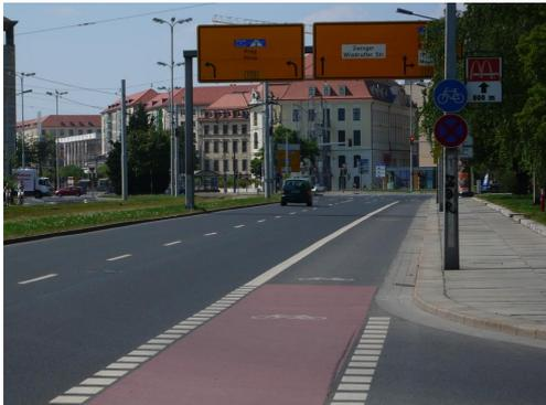
Abbildung 2: Grunaer Straße: Rückbau einer Fahrspur und Anlage Radstreifen
