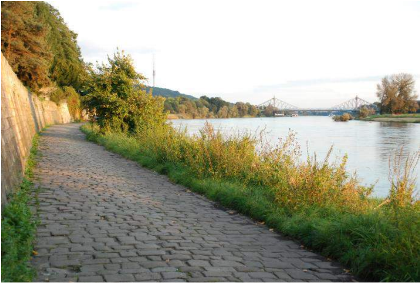
Abb. 5: Körnerweg 2014. Verlegebild der 1952 gepflasterten Oberfläche
