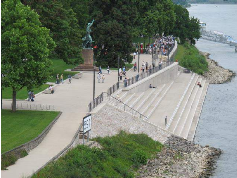
Abb. 7: Asphaltierte, oberflächenbeschichtete Wege am Rheinufer (Koblenz). 29
