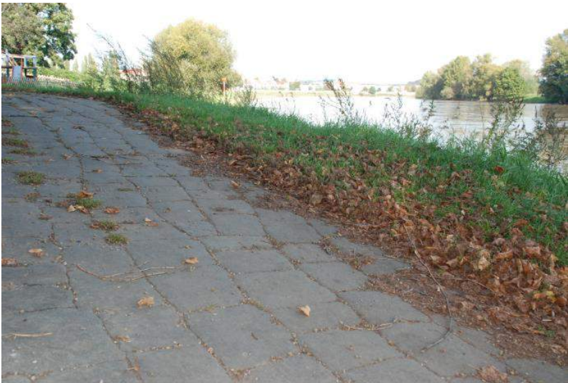
Abb. 6: Altmickten 2014. Verlegebild einer Pflasterung aus den 1860er Jahren
