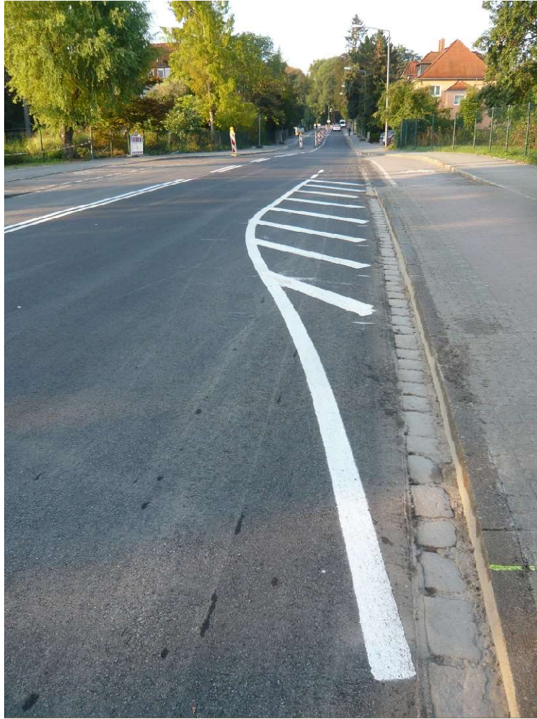
Erneuerter Einfädelbereich Rayskistraße
