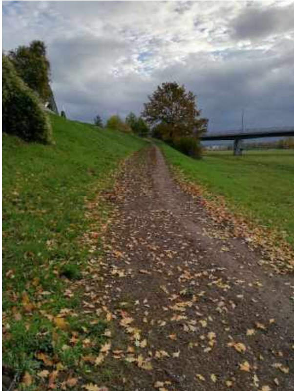
Baulich angelegte Rampe Höhe Sternstraße
