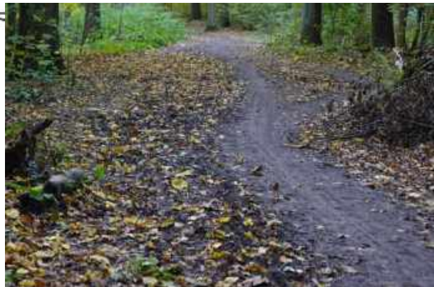
Foto Oktober 2017 (Mangel 783 Radverkehrskonzept „Wegeoberfläche nicht alltagstauglich (Aufweichen und Schlamm bei Nässe, Staub bei Trockenheit)“)
