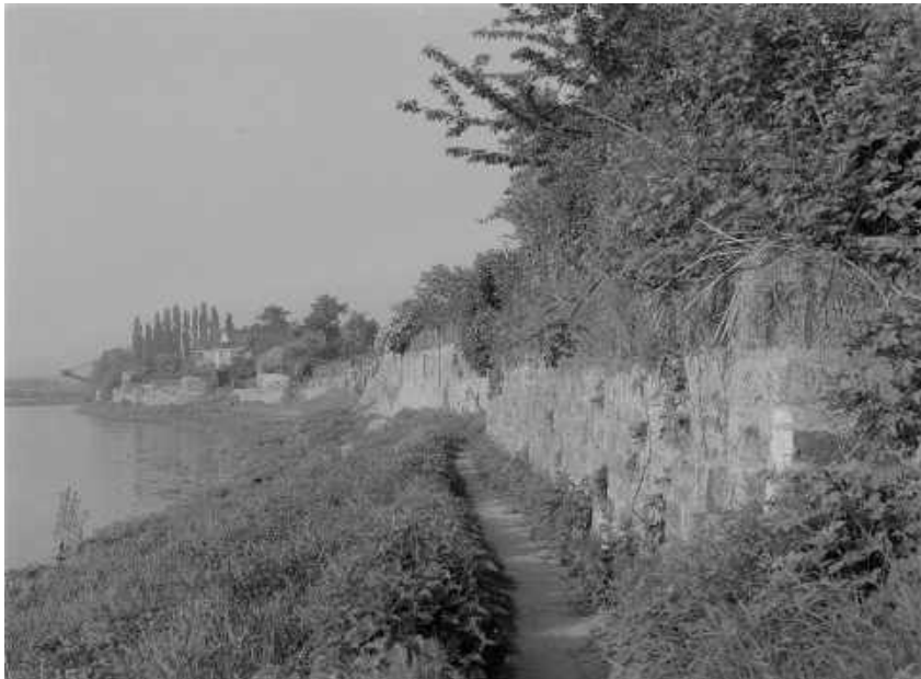
Dresden-Mickten, Hochwasserschutzmauer und Treidelpfad
