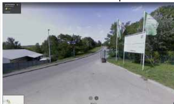
Alternative Zufahrt mit Schranke (Blick Richtung Hammerweg)
