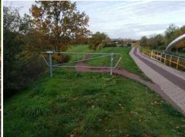
Schranke gegen Befahren mit Kfz
