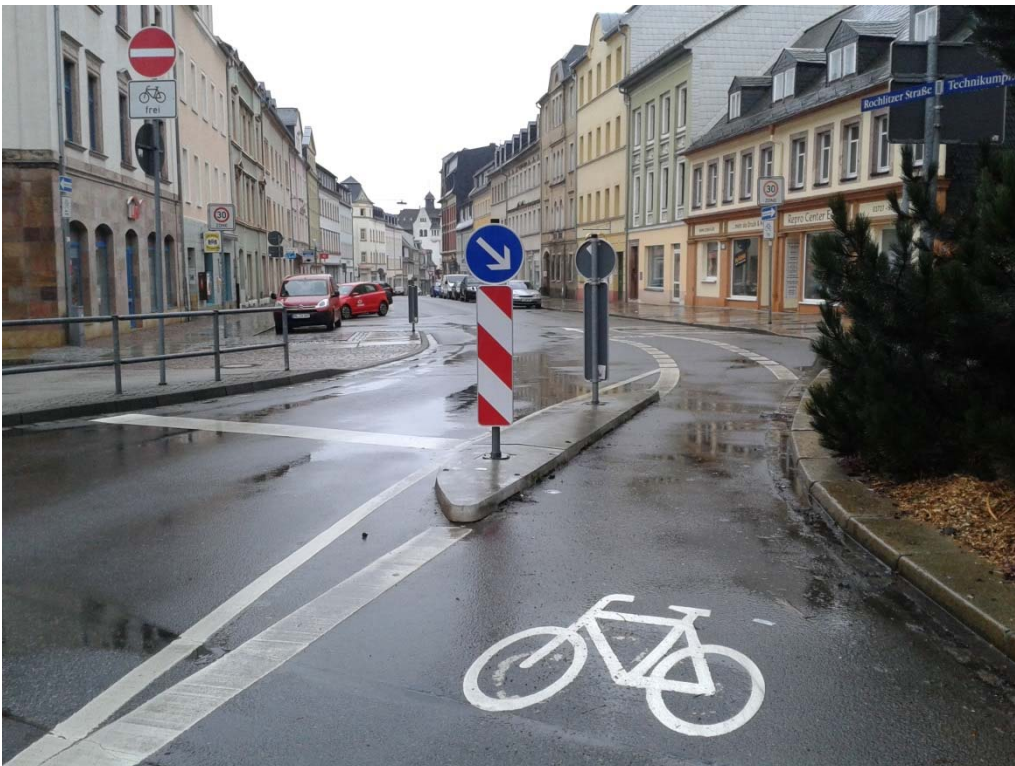
Beispiel für einen Fahrbahnteiler (Mittweida).
