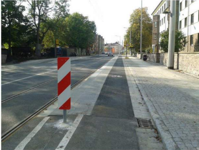
DRESDEN: Pennricher Straße Haltestelle Burckstraße mit Warnbake
